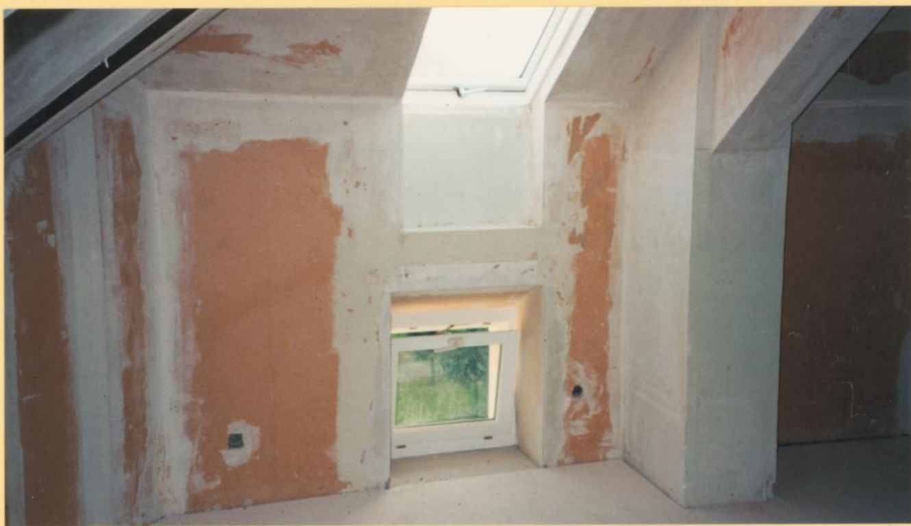
DACHGEJCHOSSAUSBAU MIT DER WIEDERHERSTELLUNG DER FENSTER IM TRIGLYPHENFRIES.
