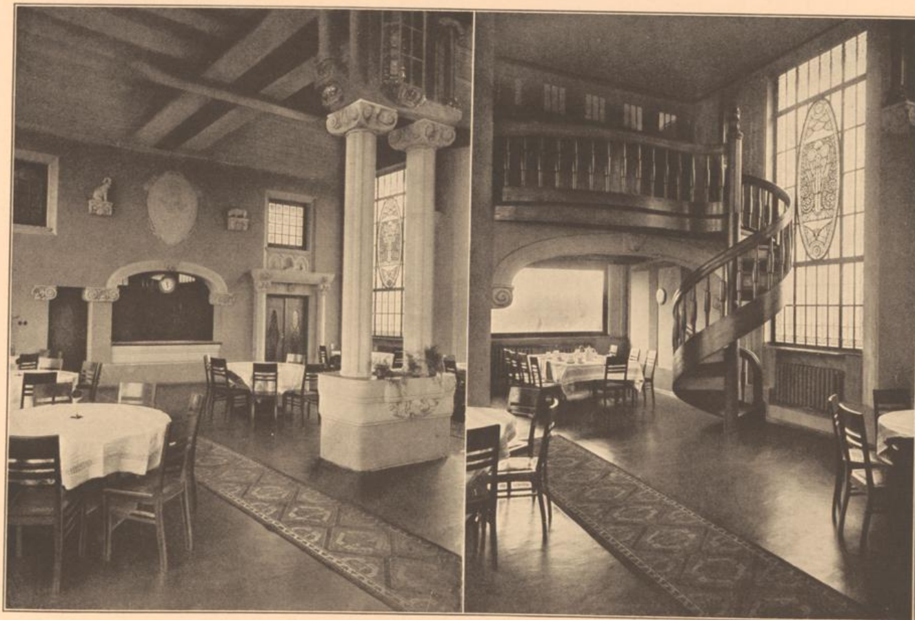
Teilansicht des Speisesaals
