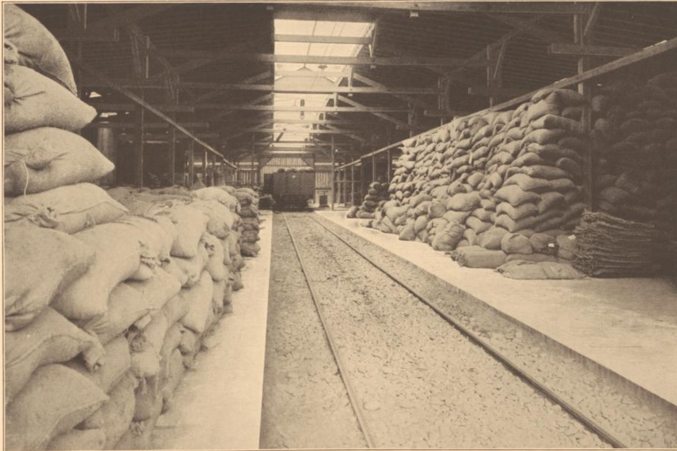
Innenansicht eines Lagerraumes für Oelfrüchte
