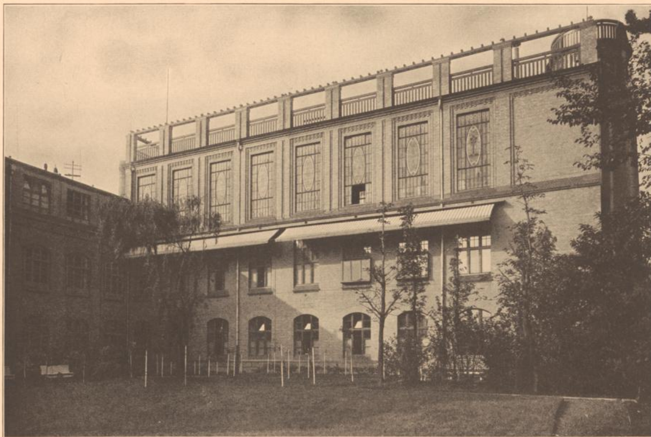
Hinterer Flügel des Verwaltungsgebäudes mit Dachgarten
