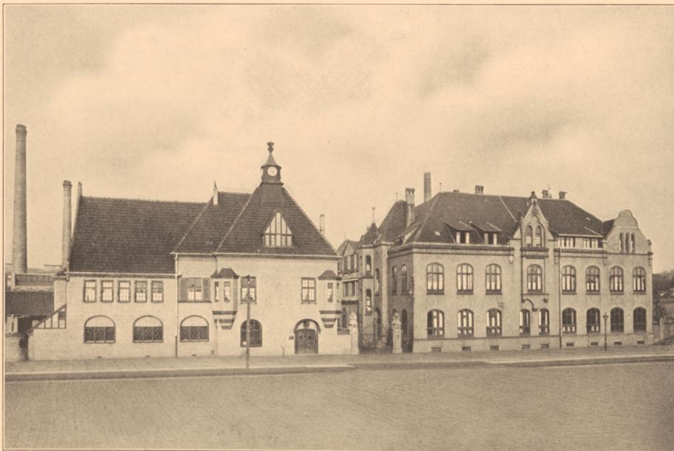
Portierhaus und Straßenansicht des Verwaltungsgebäudes
