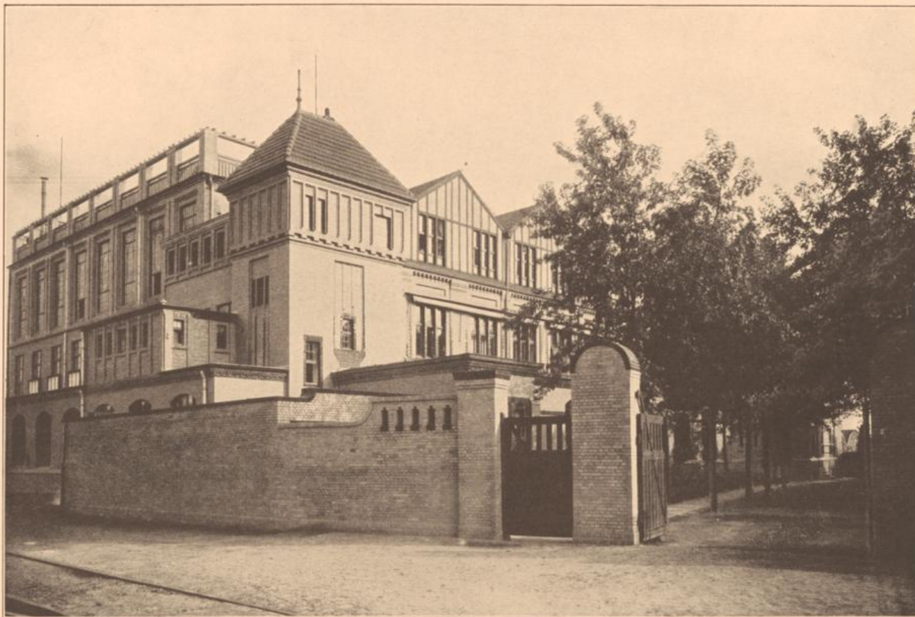
Hinterfront des Verwaltungsgebäudes und Einfahrt zur Fabrik
