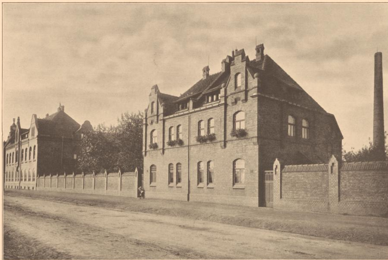
Teilansicht von Beamtenwohnungen
