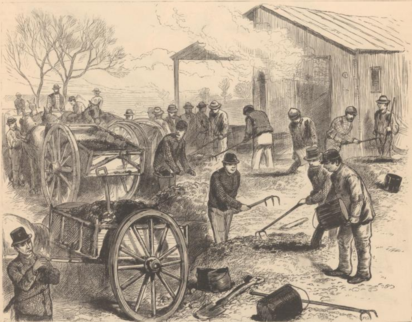
Anlage von Asphaltwegen.
