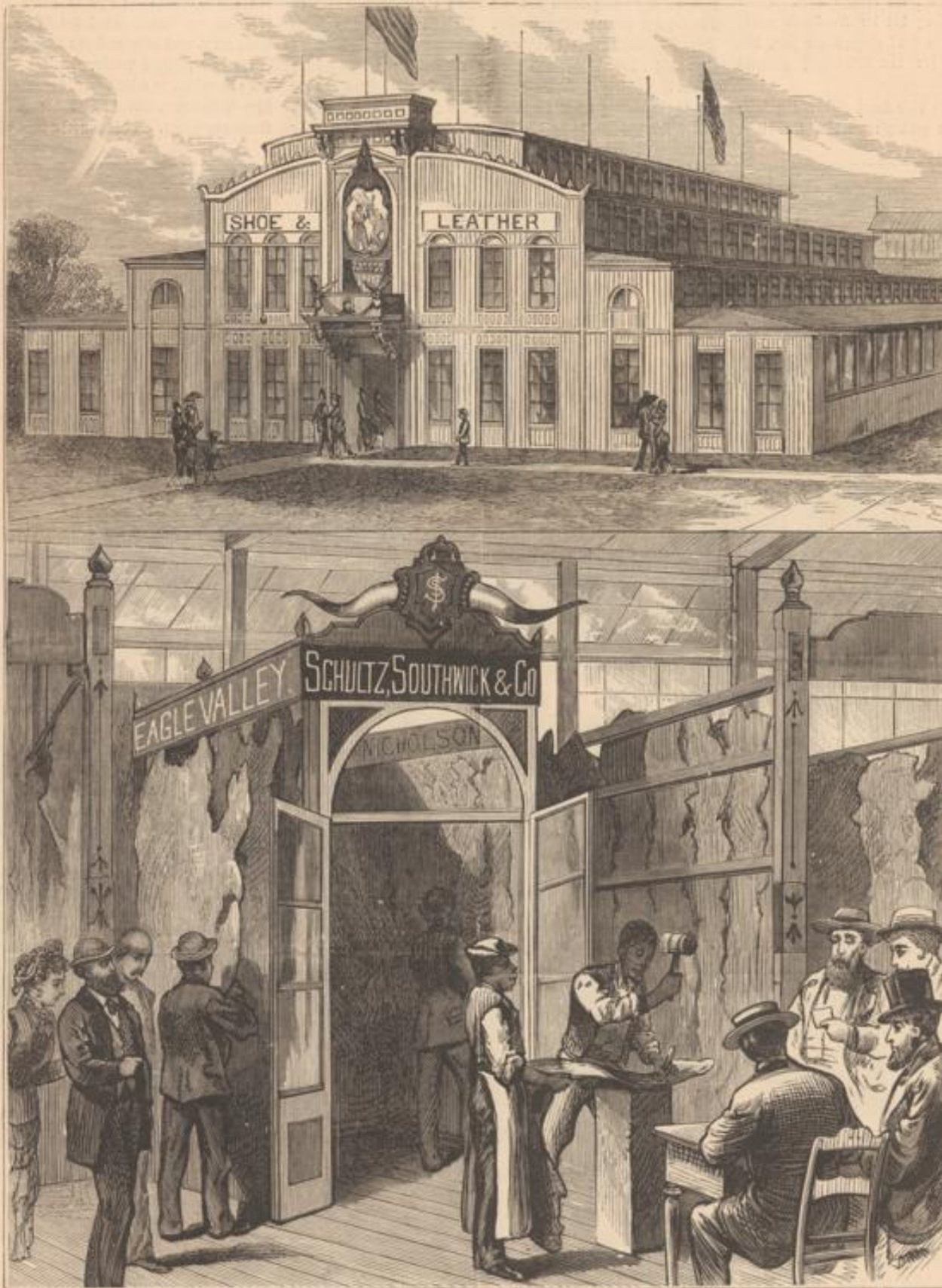
Schuh- und Leder-Gebäude. — Ausstellung der Herren Schultz, Southwick & Co.
