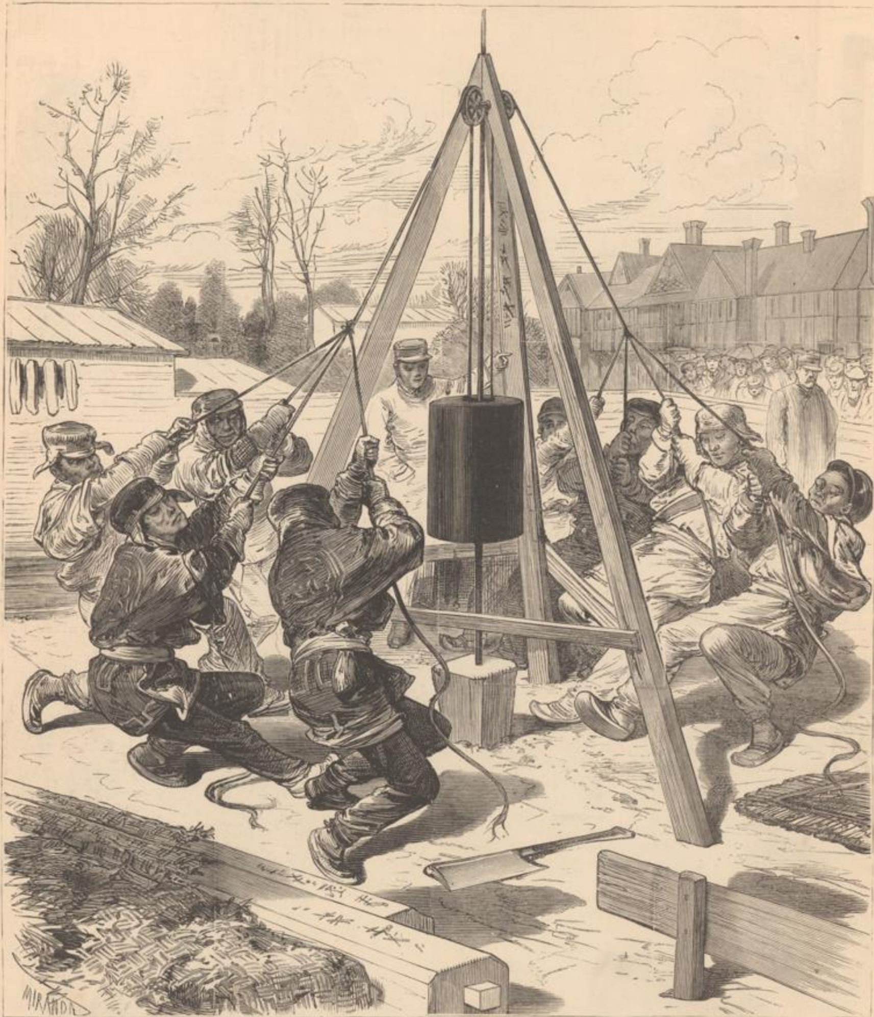
Einrammen von Pfählen als Fundament für das Japanische Gebäude.
