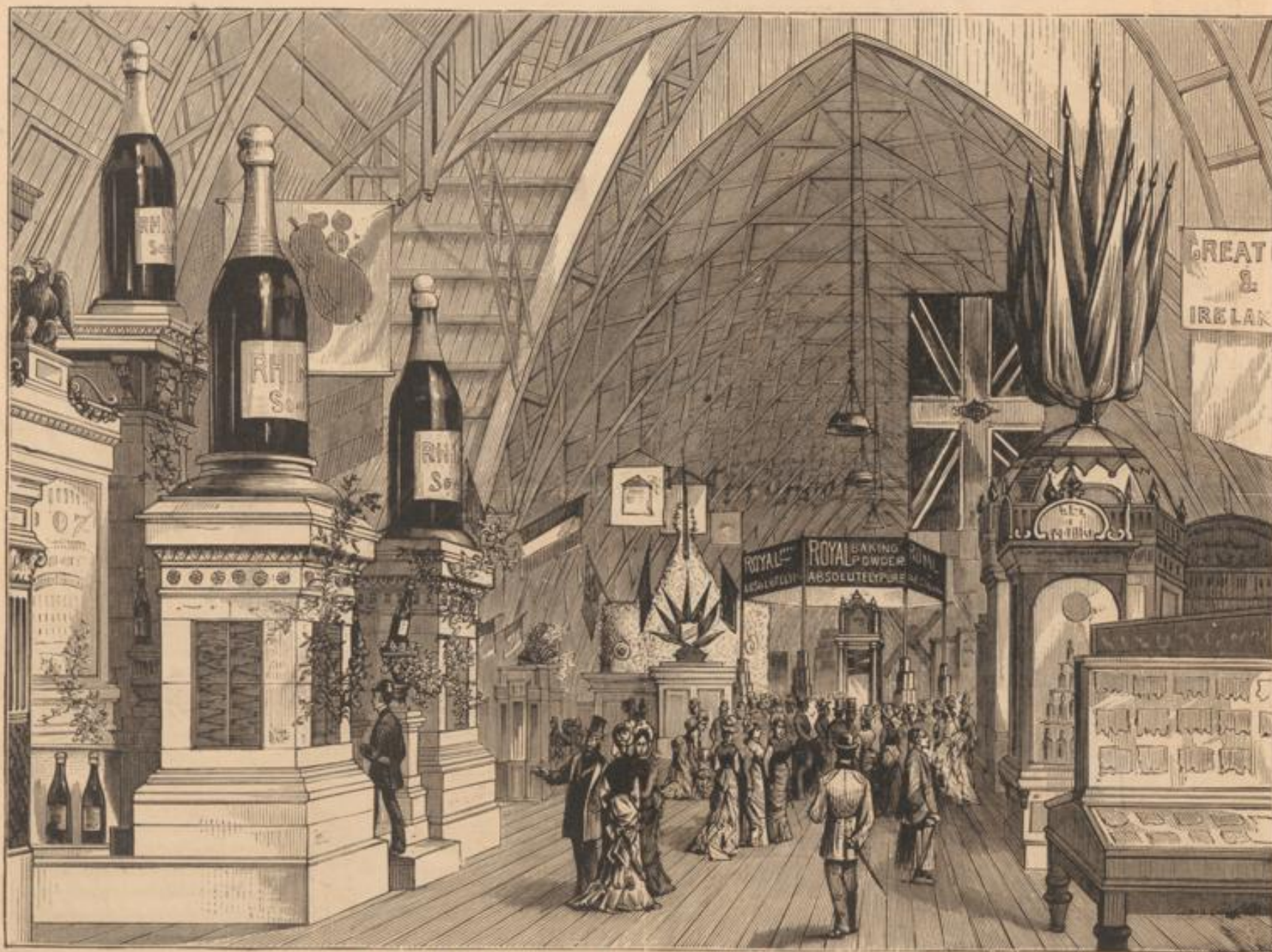
Ausstellung der „Royal Baking Powder Company“ in der Ackerbau-Halle.
