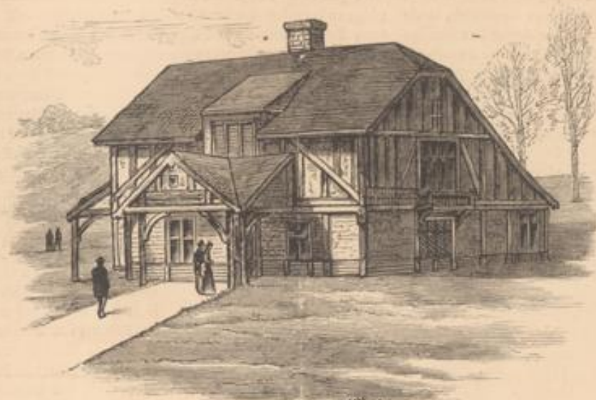
Gebäude des Staates Connecticut.
