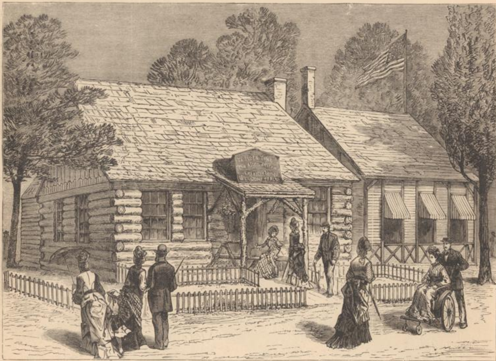
Neuere Ansicht der New-England Küche.
