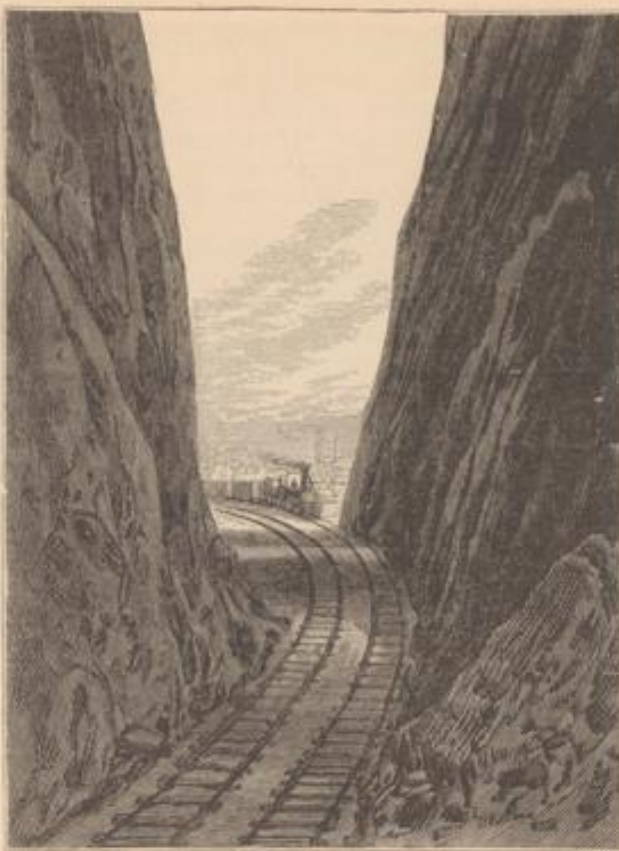
Durchfahrt bei Bergen Hill, nahe Jersey-City.
