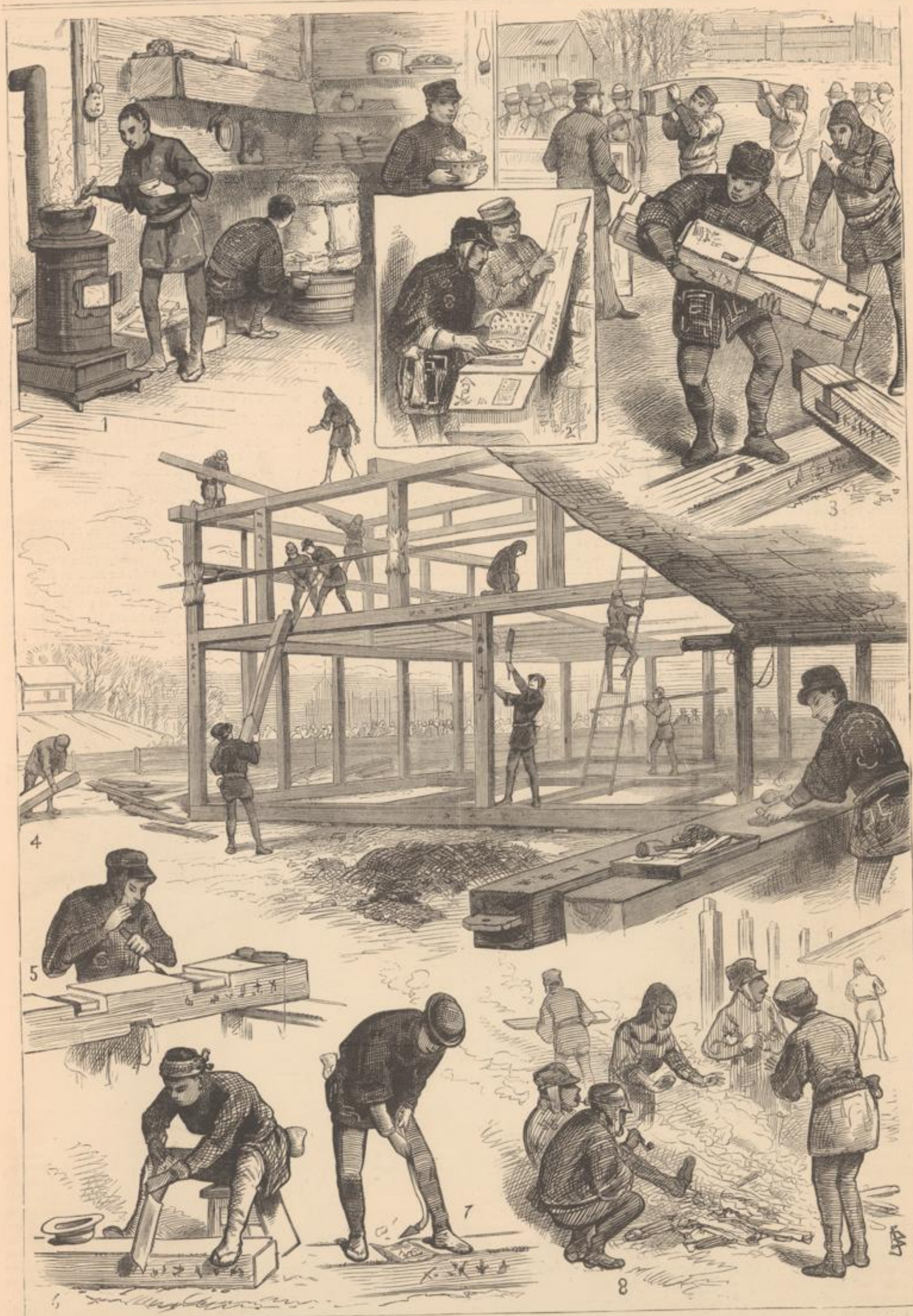
1) Japanische Arbeiter bereiten ihre Mahlzeit. 2) Japanische Arbeiter studiren die Pläne. 3) Japanische Arbeiter bringen das von Japan mitgeführte Bauholz auf den Display. 4) Bau eines japanischen Wohnhauses. 5, 6, 7) Japanische Zimmerleute an der Arbeit. 8) Japanesen am Feuer.
