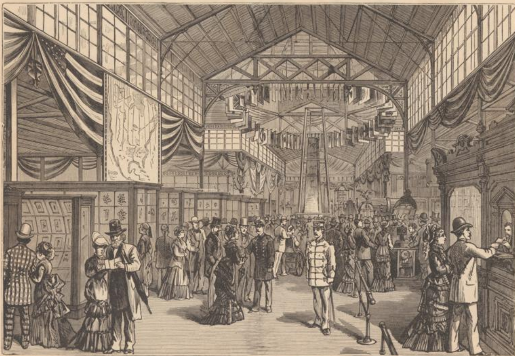
Innere Ansicht des Post-Office Flügels.
