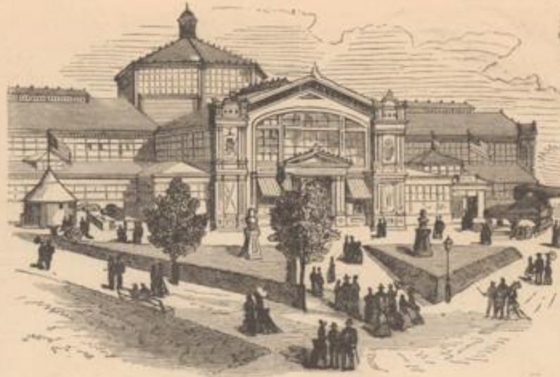
Neuere Ansicht des Vereinigten Staaten Regierungs-Gebäudes.
