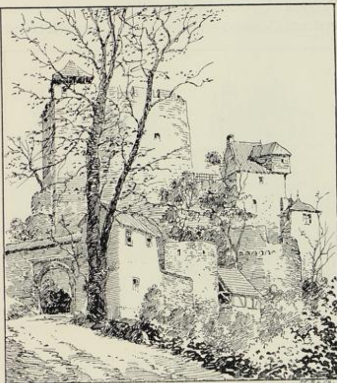
Burg Hohlenfels, von Westen.
