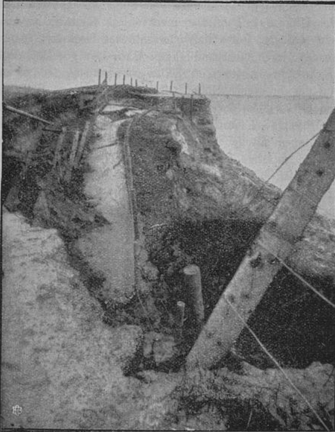
Fig. 6. Höhenweg auf der Koppel Hochhorst nach der Sturmflut am 31. Dez. 1904.
