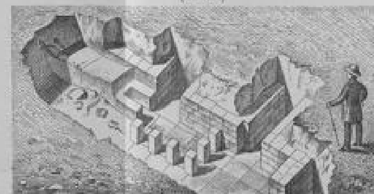
Fig. 16. Perspective des Hypocaustum's i zu Marköbel (1:50)
