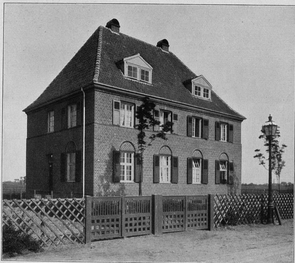
Krefeld-Linn. Arbeiterhaus. Architekt August Biebricher.
