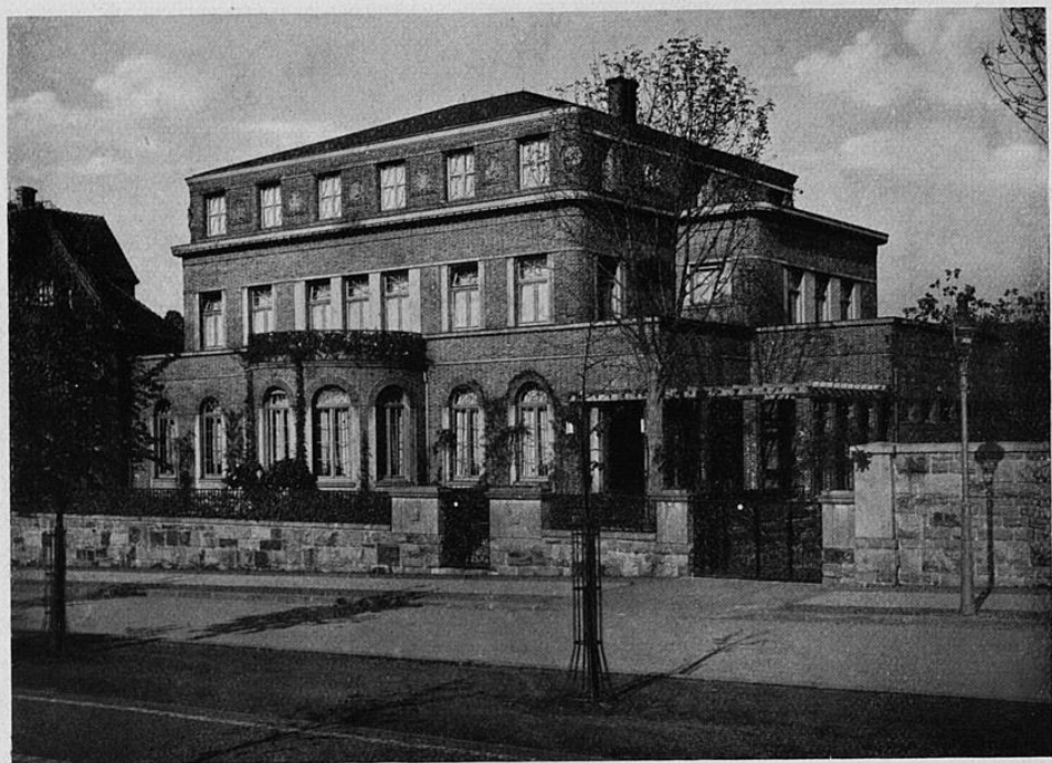
Essen — Haus Herzberg. Erbaut 1913. Architekt Edmund Körner.
