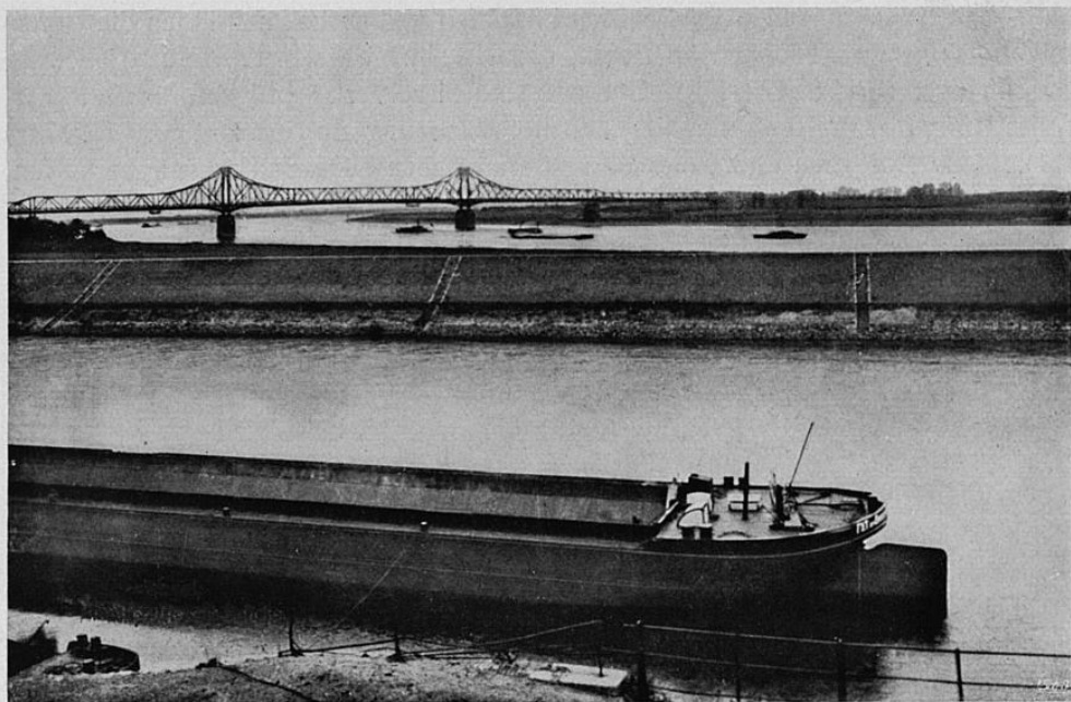
Wesel. Südliche Rheinbrücke.
