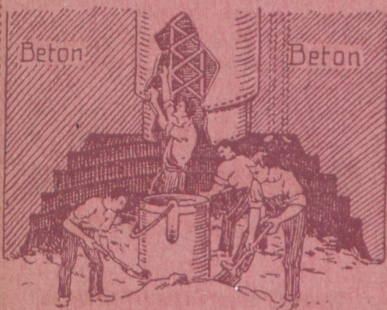
Bildprobe: Dutzutage werden Caissons fast immer aus Beton hergestellt. Die Arbeitskammer eines Betoncaissons hat eine abgestufte Decke.
