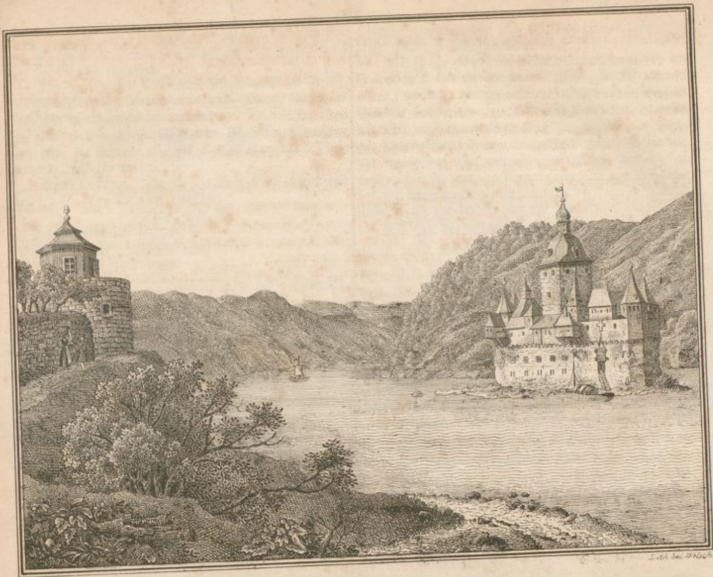
DIE PFALZ BEI CAUB.
