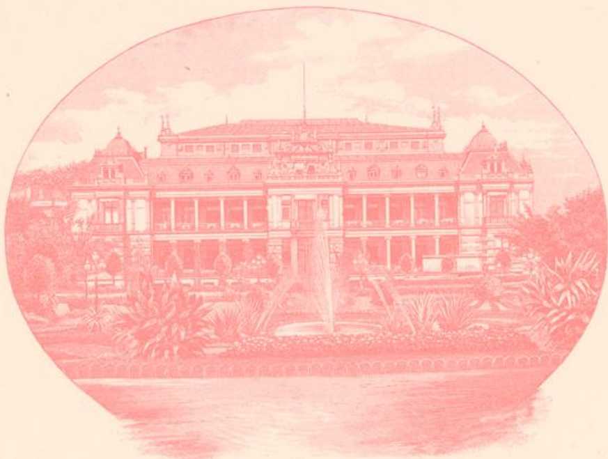
27. Hauptfront des Palmenhauses zu Frankfurt a. M.
