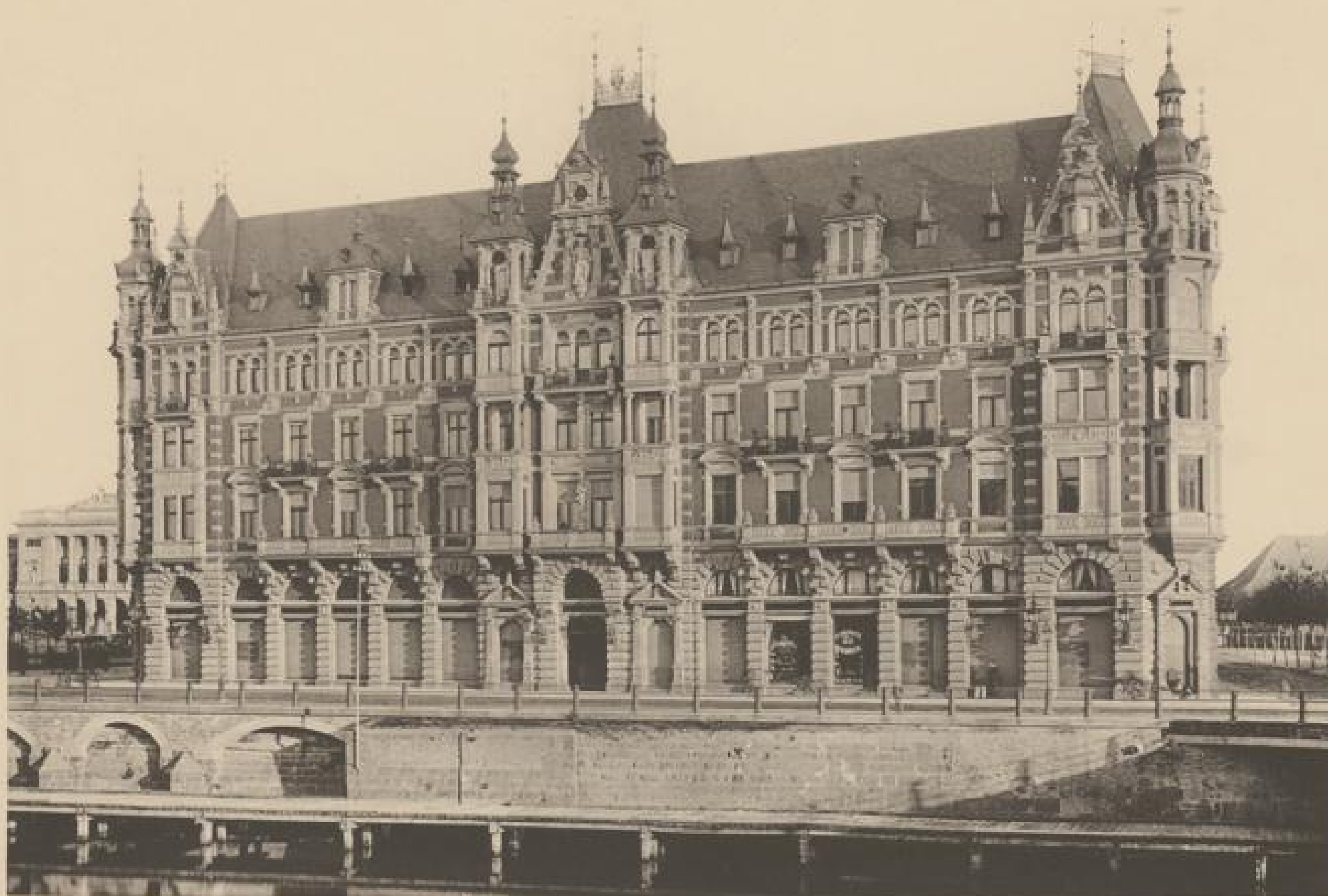
Kayser & von Grosse Arch.
